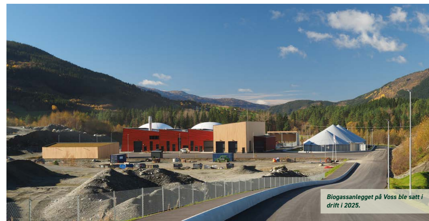
Utvidelse av BIRs deponi på Mjelstad ble sendt på høring.
