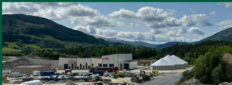
Biogassanlegget begynner å ta form, og er nesten komplett utvendig. Flere politikere kommer på omvisning og lar seg imponere av biogassanlegget og etableringen av Voss Virka, som arbeider for å etablere ny sirkulær industri i bioparken.
