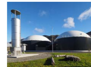
Byggingen av biogassanlegget går etter planen, og nå er kupler på toppen av rånetanker på plass. Det arbeides med fasade og elektriske og mekaniske installasjoner, og utover høsten starter vi med testing og idriftssettelse av utstyr.
