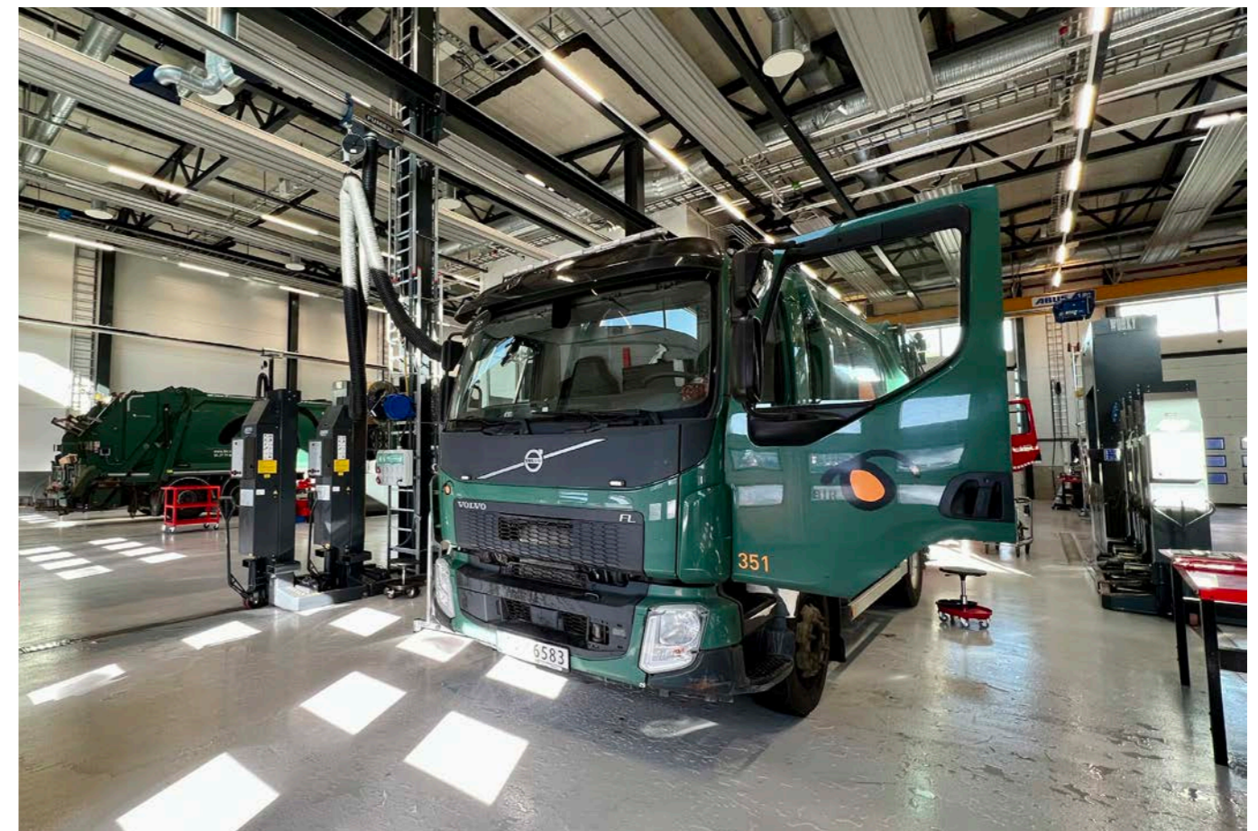
Det nye verkstedet på Espehaugen 52 tas i bruk.
